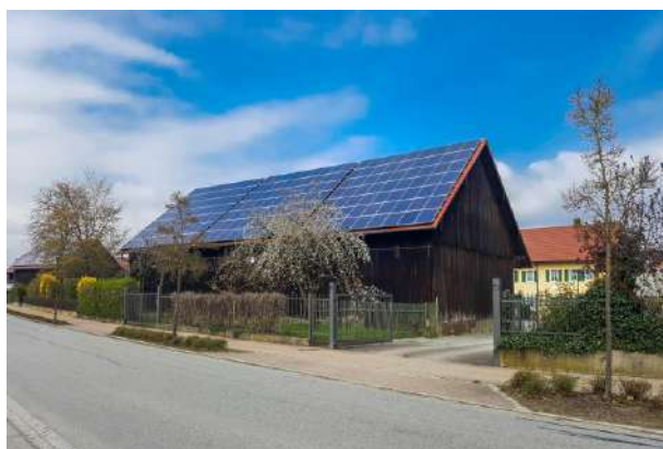
impianto su capannone
