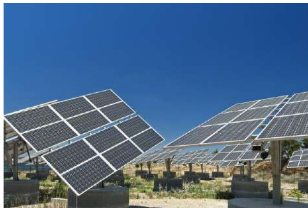
impianto ad inseguimento
