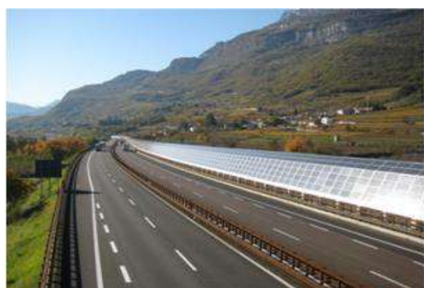
impianto su autostrada (barriera acustica)
