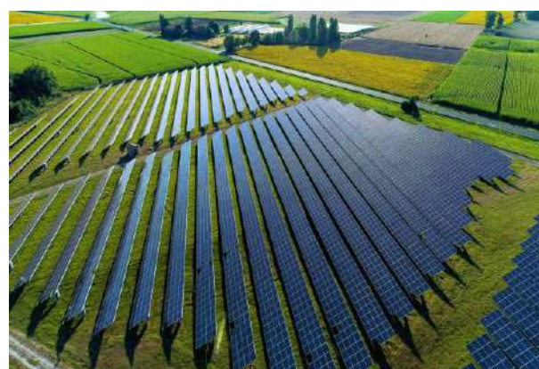
impianto a terra
