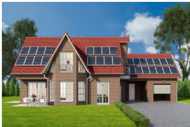
impianto a servizio di abitazione
